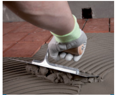
Anvendelse af Granirapid på terrasse imprægneret med Mapelastic Zero
