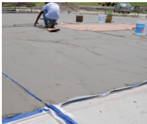
Vandtætte afretningslag med Mapelastic Zero og Mapeband
