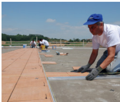
Montering af keramiske fliser med Kerabond + Isolastic
